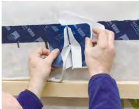
KAFLEX post, если кабель уже выведен и использование других манжет уже невозможно.
