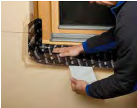
Использование в качестве изоляции под отливом.
