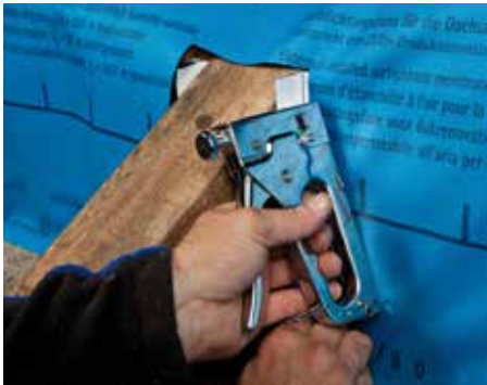
Закрепите мембрану на профиле TESCO FIX скобами.
