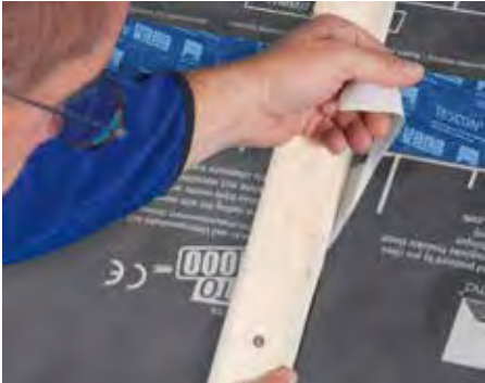
Плавню удалите разделительную пленку.
