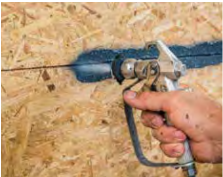
...стыков конструкционных плит,
