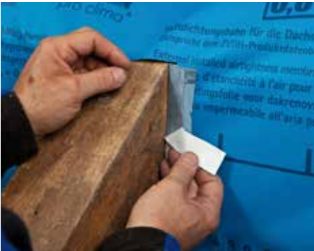
Удалите разделительную пленку с соединенной с профилем клейкой ленты и герметично приклейте на мембрану и стропило.
