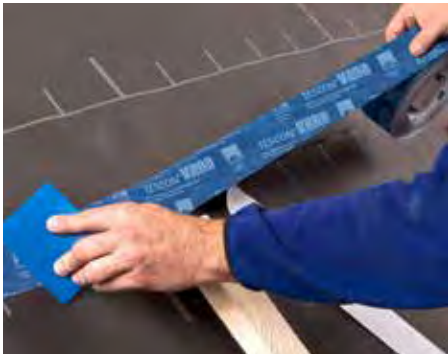
...и нахлестов ветровлагозащитных мембран снаружи.
