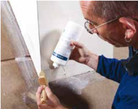
Соединение с дымовой трубой.
