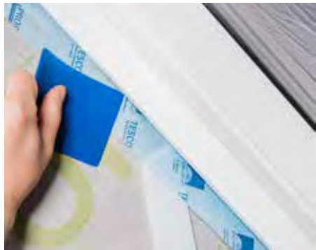
Изоляция соединений с мансардными окнами внутри,
