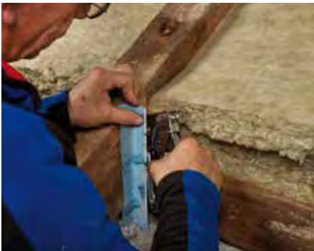
и закрепите его на стропиле.
