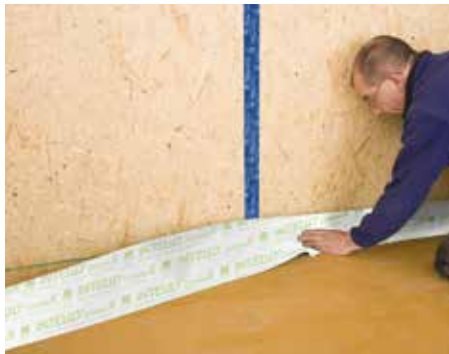
...например, с помощью INTELLO connex.
