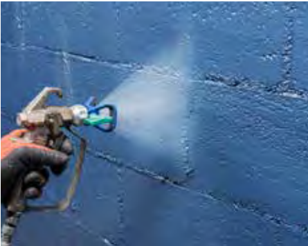
...изоляция неоштукатуренных стен
