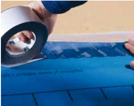
Соединение с ветровлагозащитной мембраной.
