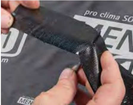
TESCON NAIDECK при вбивании гвоздей заполняет отверстие.
