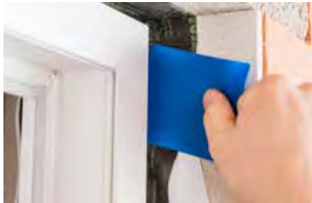
Хорошо пригладьте ленту с помощью лопаточки pro clima PRESSFIX.
