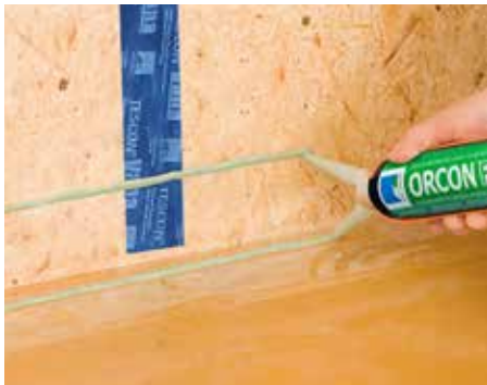
...а также для соединения конструкционных плит с полом,
