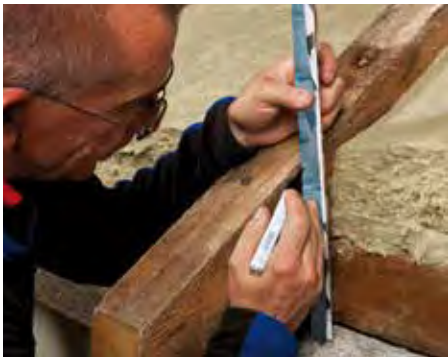
Отметьте длину до верхнего края.
