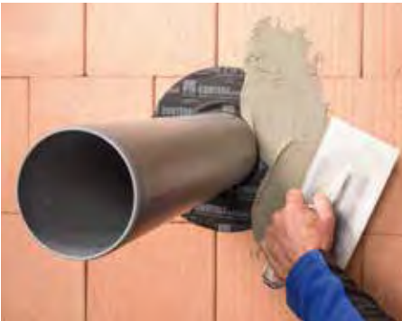
Поверх ROFLEX SOLIDO можно наносить штукатурку.
