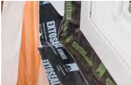
Соединения на углах должны быть воздухо непроницаемыми и стойкими к ударному воздействию дождя.
