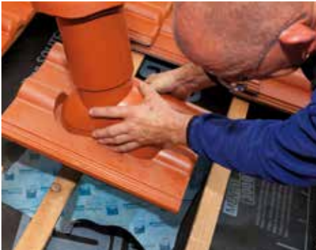
Соединение с вентиляционной трубой.
