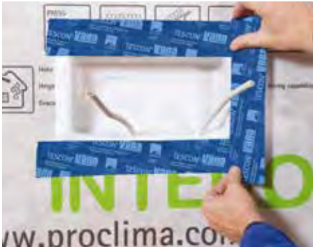
INSTAABOX создает герметичный контур в зоне монтажа переключателей и подрозетников.
