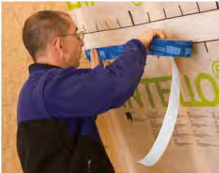
Склеивание нахлестов пароизоляционных мембран внутри,
