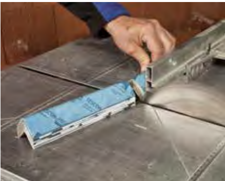
Отрежьте TESCO FIX нужной длины...
