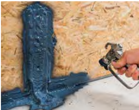
Воздухонепроницаемая изоляция крепежных элементов,
