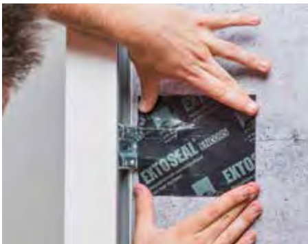
Водоотводящая изоляция элементов крепления.
