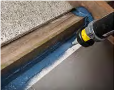
...и сложных узлов при реконструкции.
