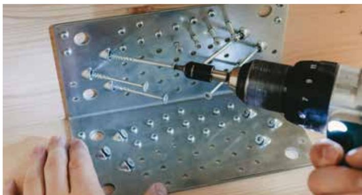
Фиксация крепежных элементов (пластины сталь-дерево)
